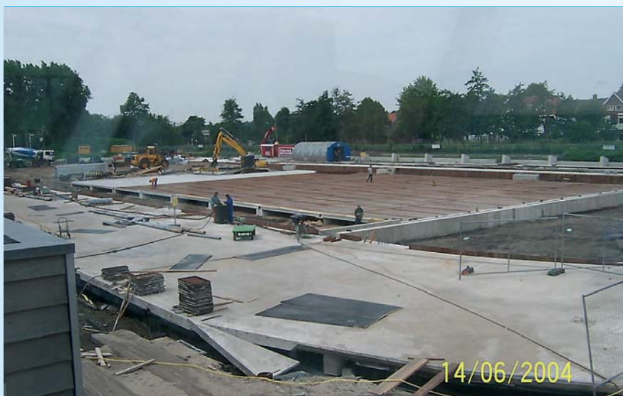
Afbeelding 6 – Overzicht van de werkzaamheden aan de kunstijsbaan Kennemerland. In het midden wordt de 60×30-baan aangelegd.
